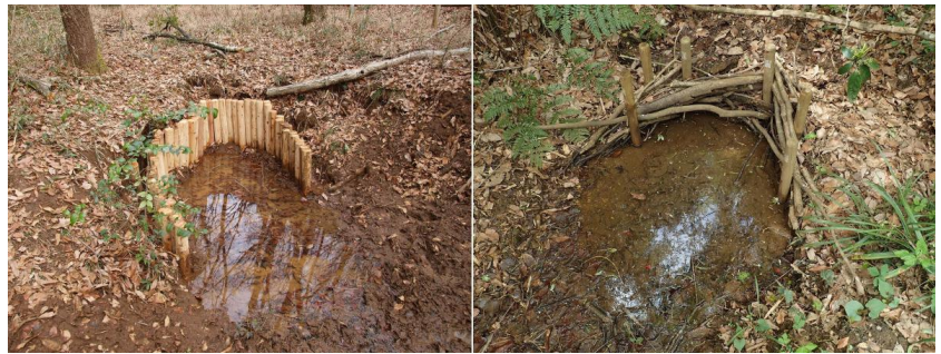
図 5.12: 土留杭（左図）としがら柵（右図）。
